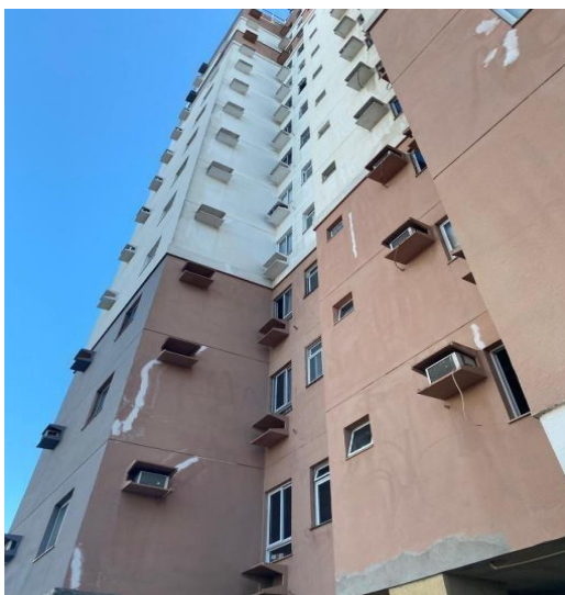
Figura 11: Aplicação de selante e reparos na fachada do edifício.
