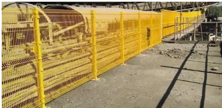
Figura 3 – Tela de alambrado especial metálica – barreira física nas laterais
