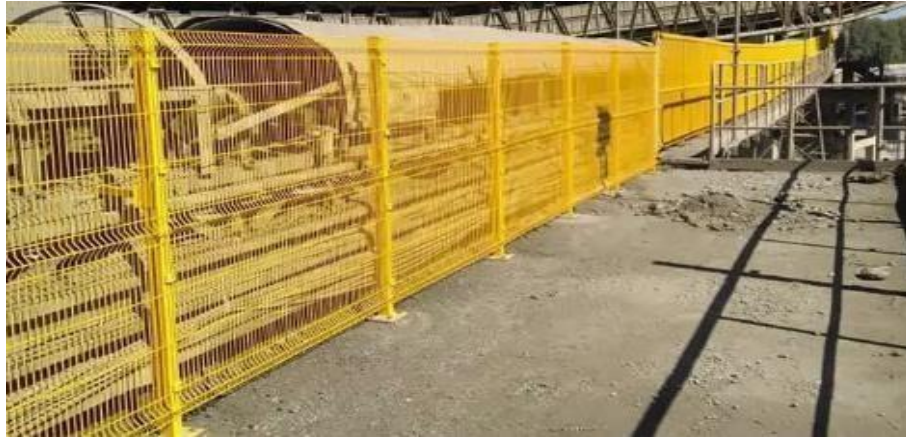
Figura 3 – Tela de alambrado especial metálica – barreira física nas laterais
