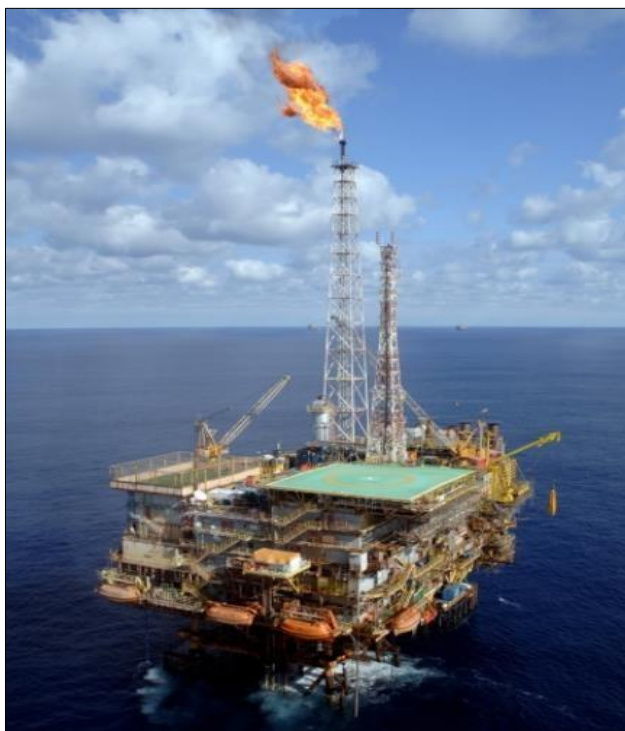
Imagem 1 – Plataforma fixa de Garoupa, localizada na Bacia de Campos (RJ)
