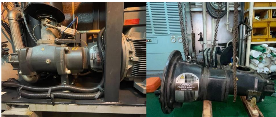
Imagem 4 - Desacoplamento do compressor
