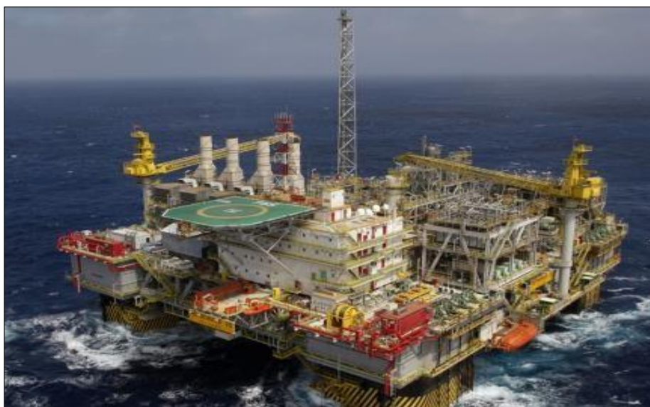
Imagem 2 – Plataforma semissubmersível P-55
