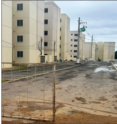
Figura 2: Visão geral da obra
