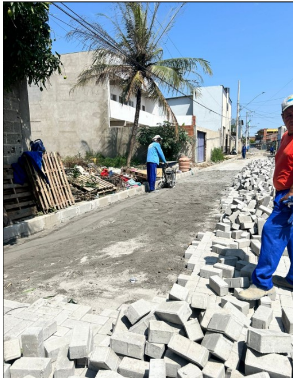
Figura 13: Processo de posicionamento de blocos, que exige movimentos repetitivos de abaixar e levantar, causando fadiga muscular.
