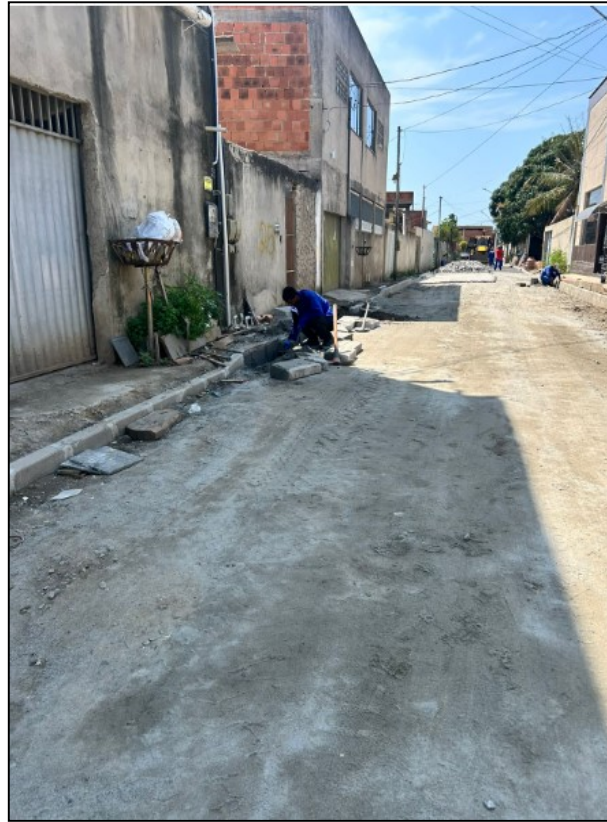
Figura 8: Execução de obra de saneamento e drenagem no bairro Serra Dourada
