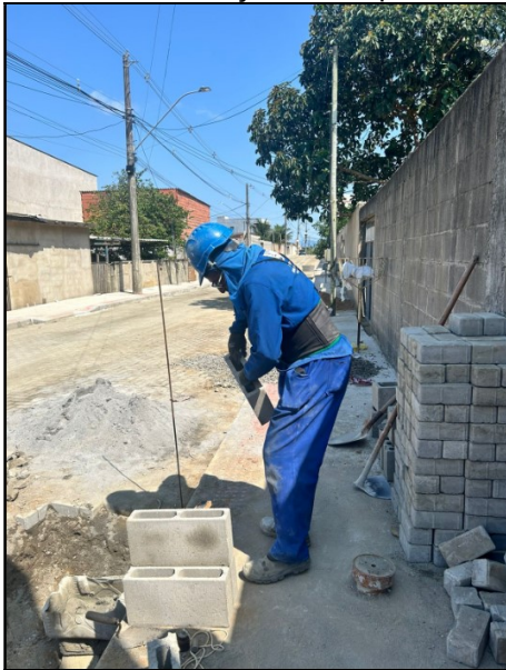
Figura 9: Trabalhador levantando blocos de concreto, expondo-se a riscos de lesão lombar devido ao esforço físico repetitivo.
