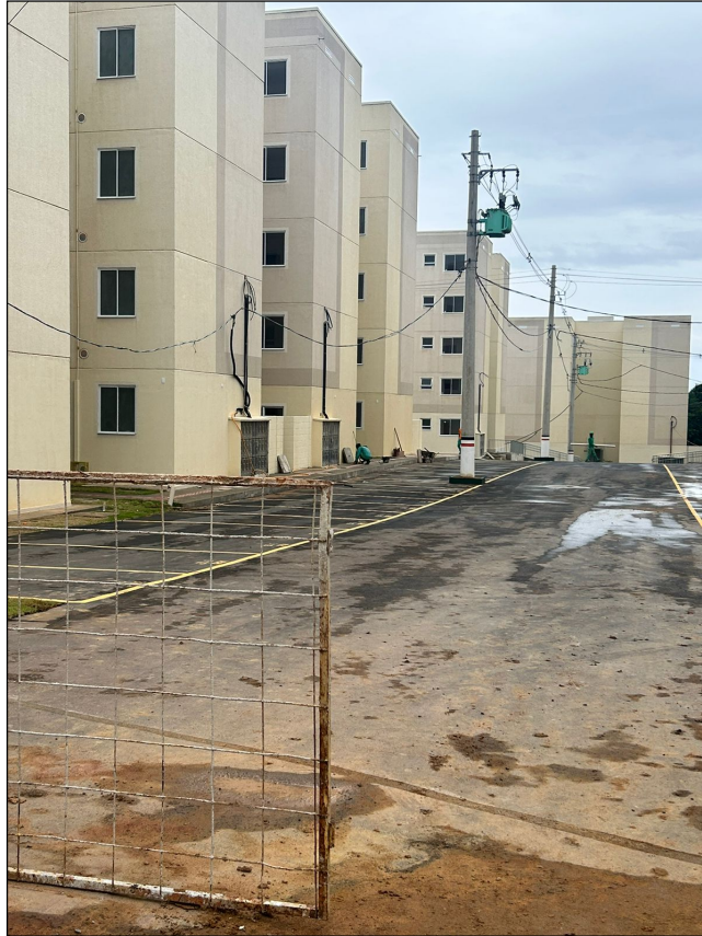
Figura 2: Visão geral da obra
