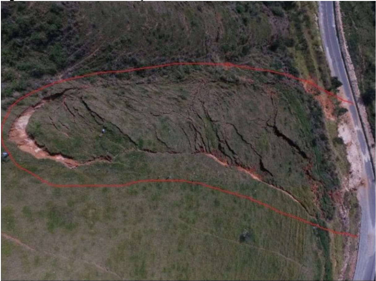
Figura 1 – Trecho Serra da Aliança – Deslizamento de encosta
