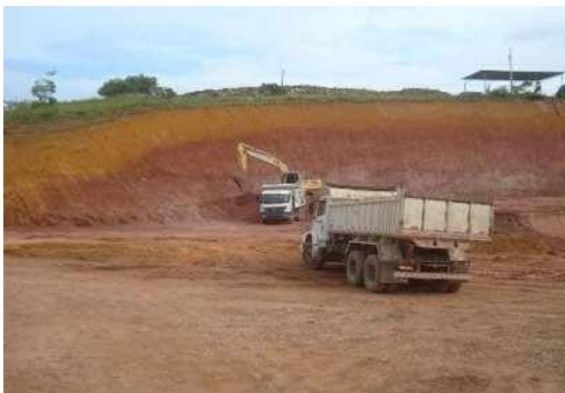
Figura 6 – Terraplanagem da base do aterro.
