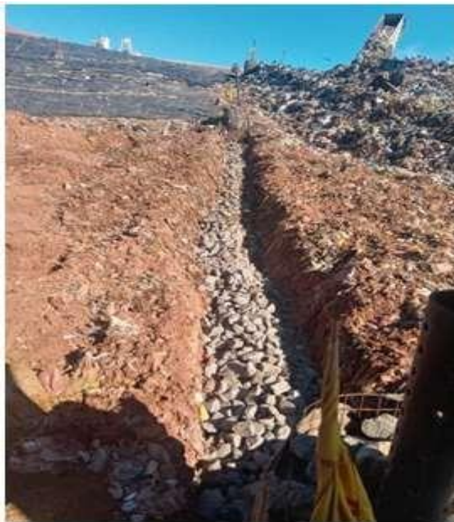
Figura 7 - Dreno de camadas de lixiviados
