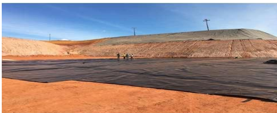
Figura 4 – Preparação do solo com impermeabilizantes.
