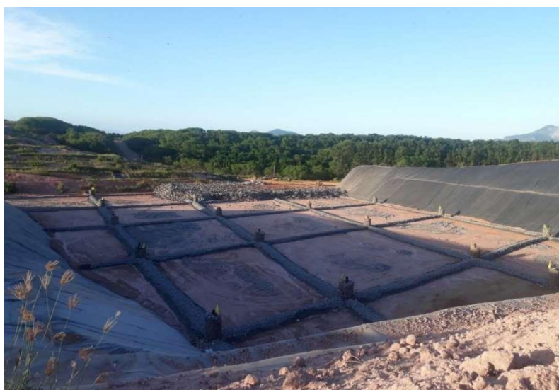
Figura 8 - Sistema de drenagem da base de lixiviados.
