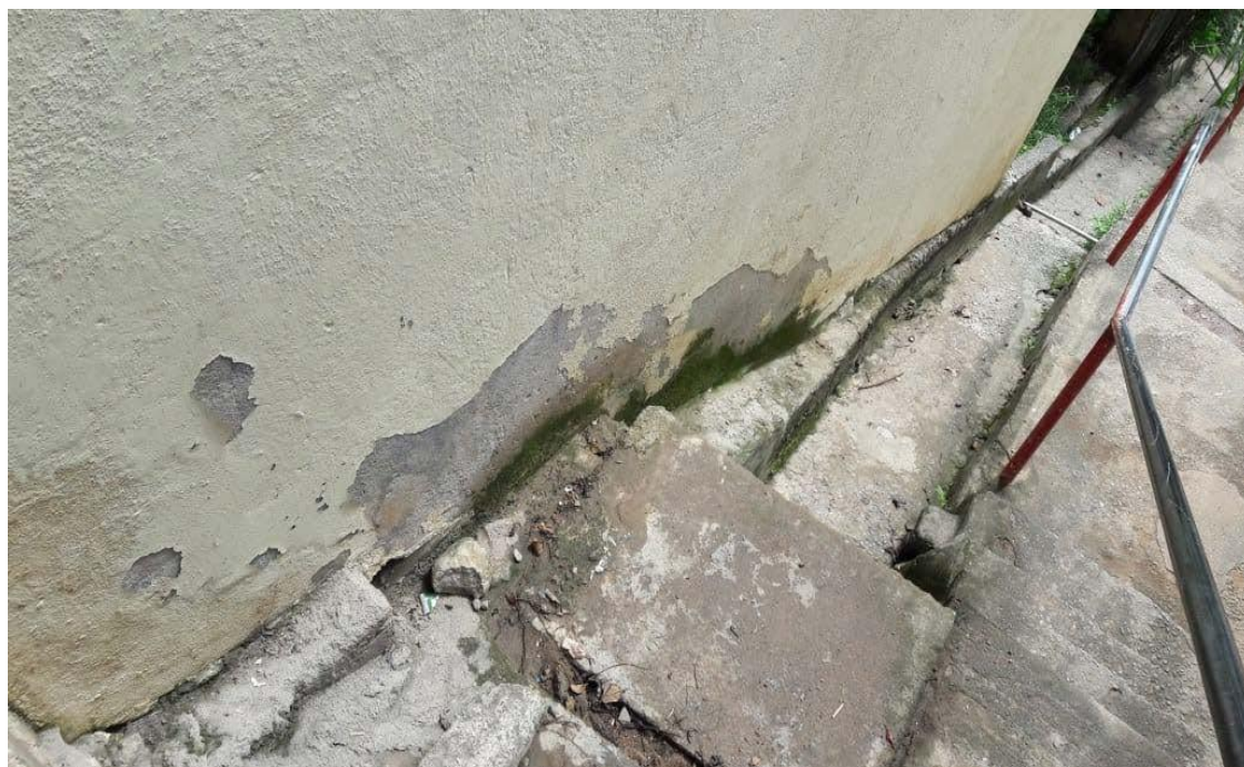
Figura 11 – Decida d'água ao lado da edificação
