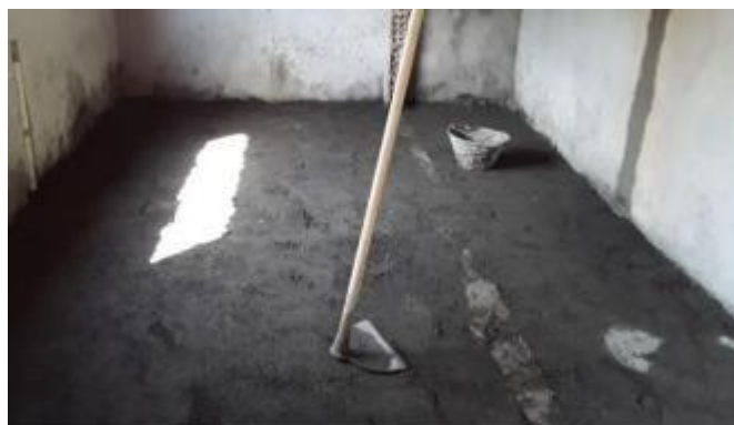
Figura 4: Nivelamento do aterro feito com a enxada
