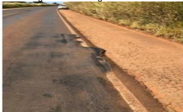
Imagem 4 -Escorregamento asfáltico
