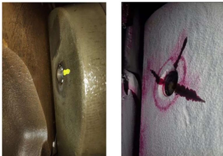
Imagem 8 - Monitoramento de trincas ao redor do furo de lubrificação
