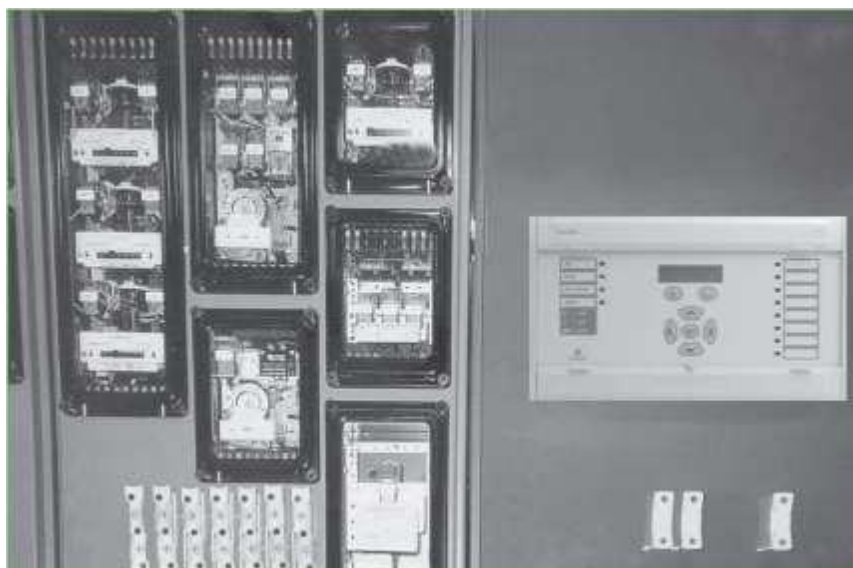
Figura 9 – Relés eletromecânicos x Relés inteligentes
