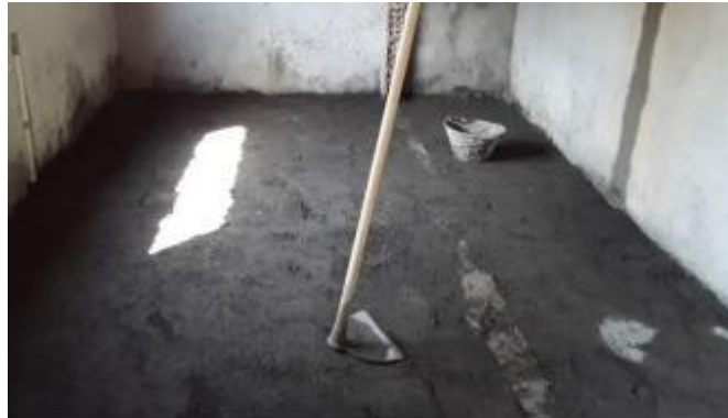
Figura 4: Nivelamento do aterro feito com a enxada
