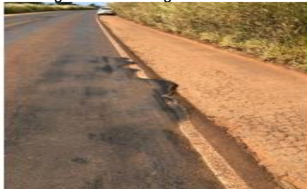
Imagem 4 -Escorregamento asfáltico
