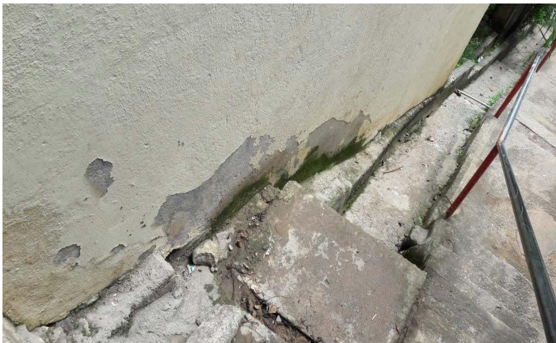
Figura 11 – Decida d'água ao lado da edificação
