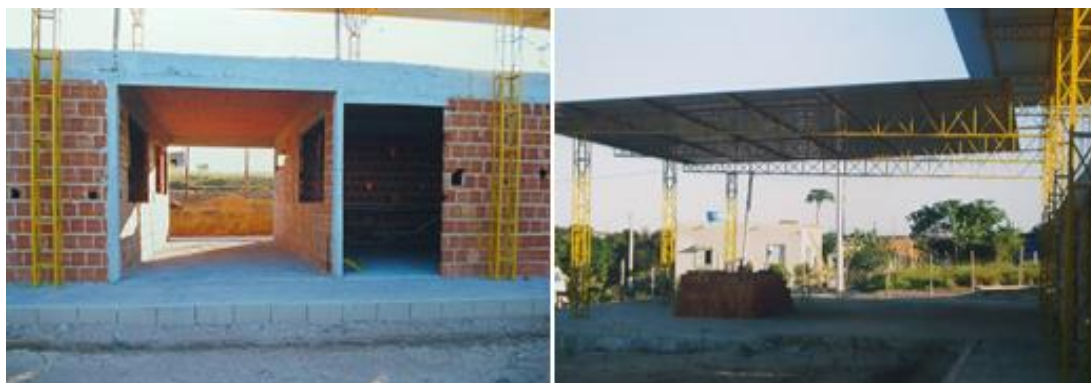
Figura 4- Nova sede sendo construída em terreno doado pelo município no bairro Ayrton Senna em São Mateus.
