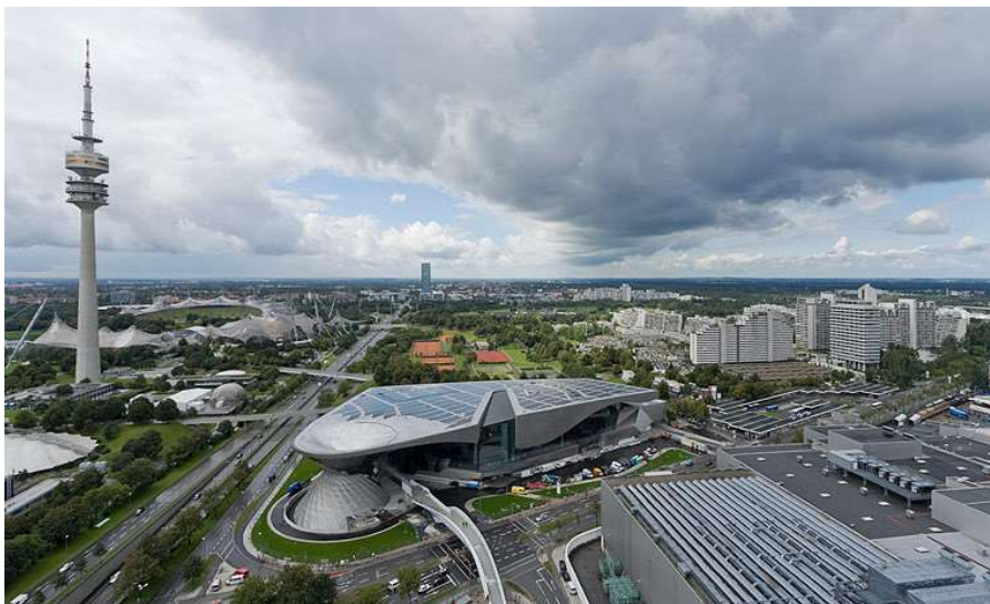
Figura 9 - Painéis fotovoltaicos na BMW Welt
