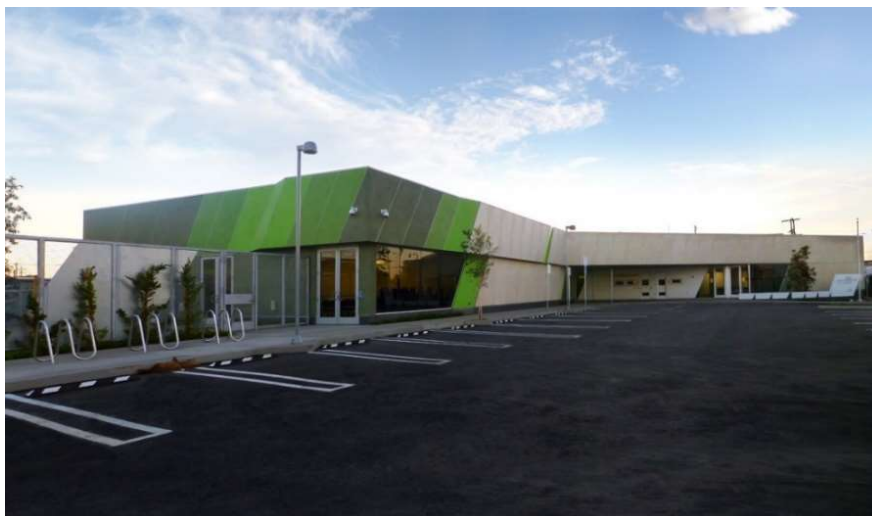
Figura 3 - Painéis pré-fabricados representando escamação de um animal
