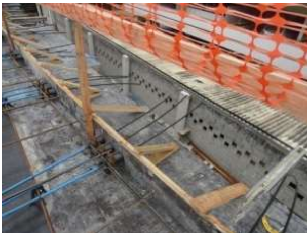
Imagem 15 – Ancoragem ativa de cabos uniformes.
