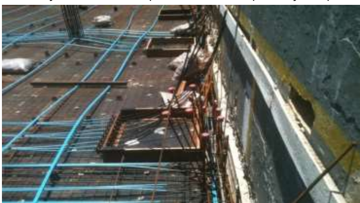
Imagem 20 – Inserção de nichos de protensão devido presença de parede de
