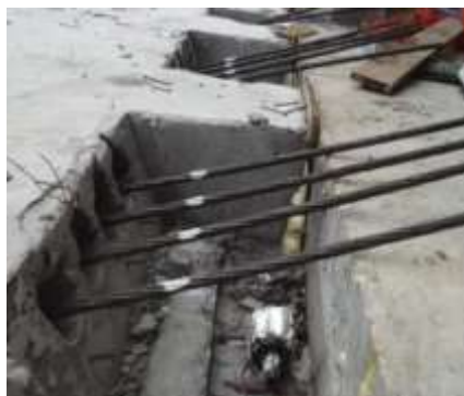
Imagem 26 – Marcação para medir o alongamento do cabo.
