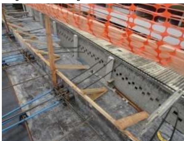
Imagem 15 – Ancoragem ativa de cabos uniformes.
