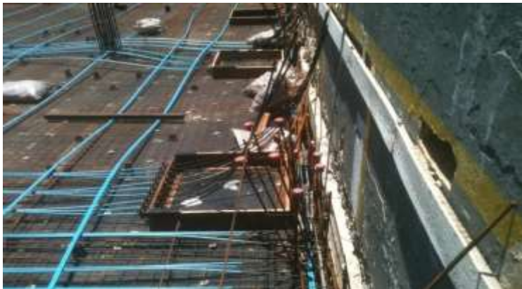
Imagem 20 – Inserção de nichos de protensão devido presença de parede de
