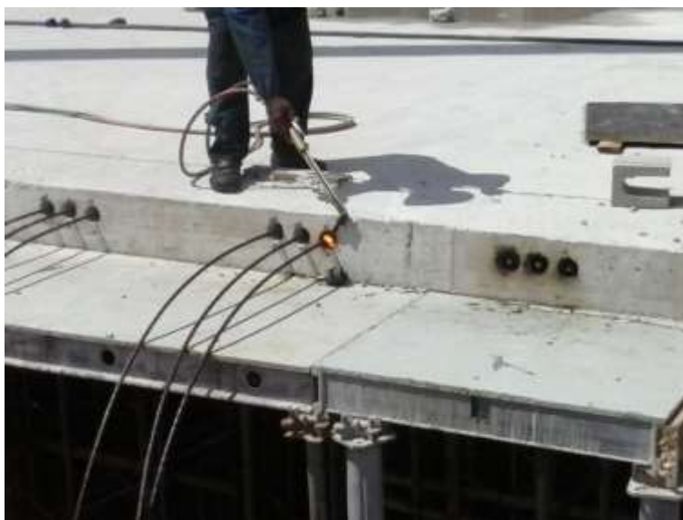
Imagem 28 - Corte das pontas dos cabos com maçarico após conferência do alongamento
