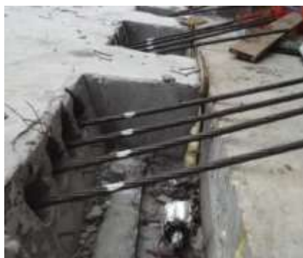
Imagem 26 – Marcação para medir o alongamento do cabo.
