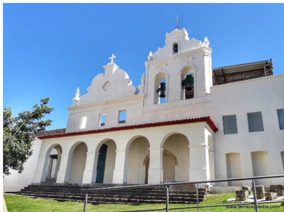
Figura 4: Convento de São Francisco
