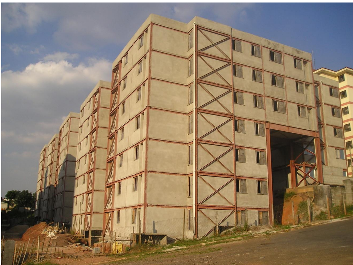
Figura 14: Mutirão em obras, destaque para as estruturas metálicas.
