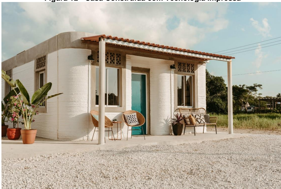
Figura 12 - Casa Construída com Tecnologia Impressa
