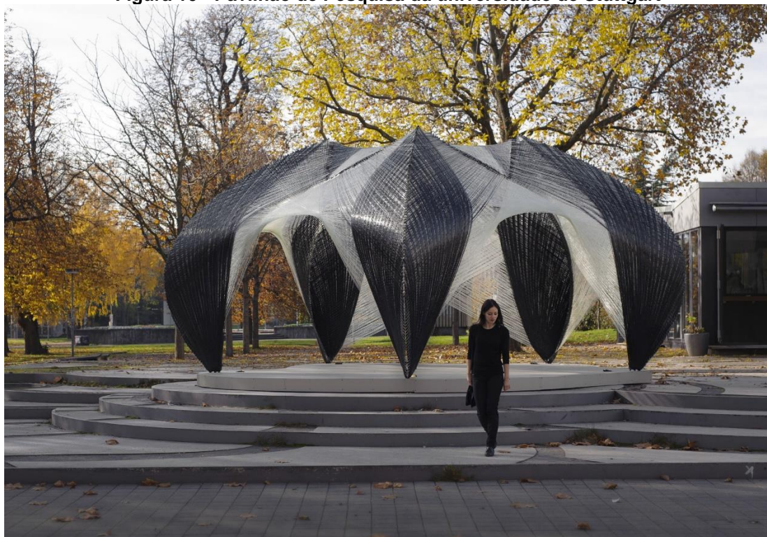
Figura 10 - Pavilhão de Pesquisa da universidade de Stuttgart
