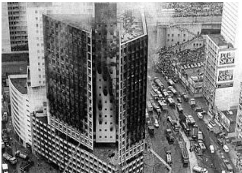
Figura 12 – Incêndio no Edifício Joelma
