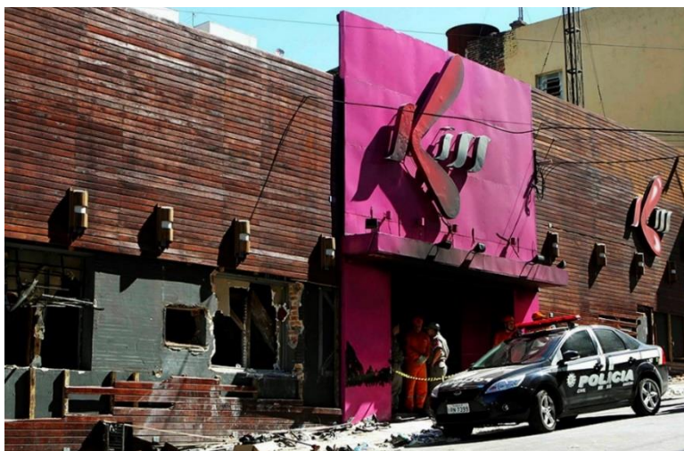
Figura 14– Fachada da Boate Kiss após incêndio
