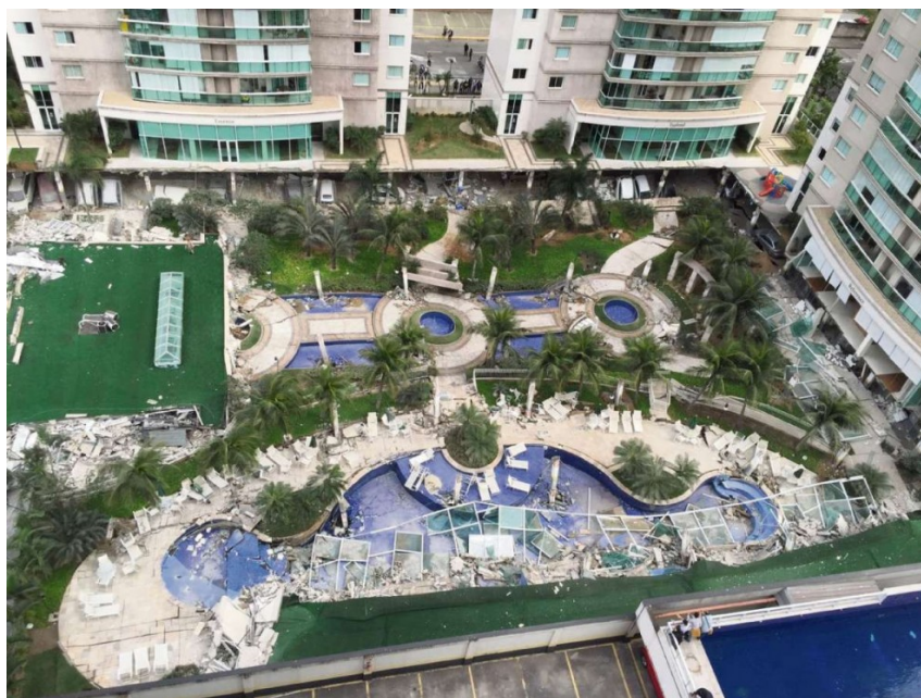
Figura 17: Área de lazer do Condomínio Grand Parc Residencial Resort desabada
