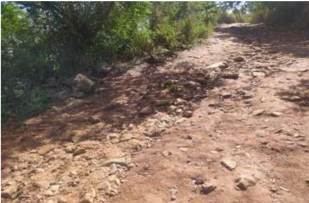
Figura 12: Desníveis/pedras soltas encontradas no percurso
