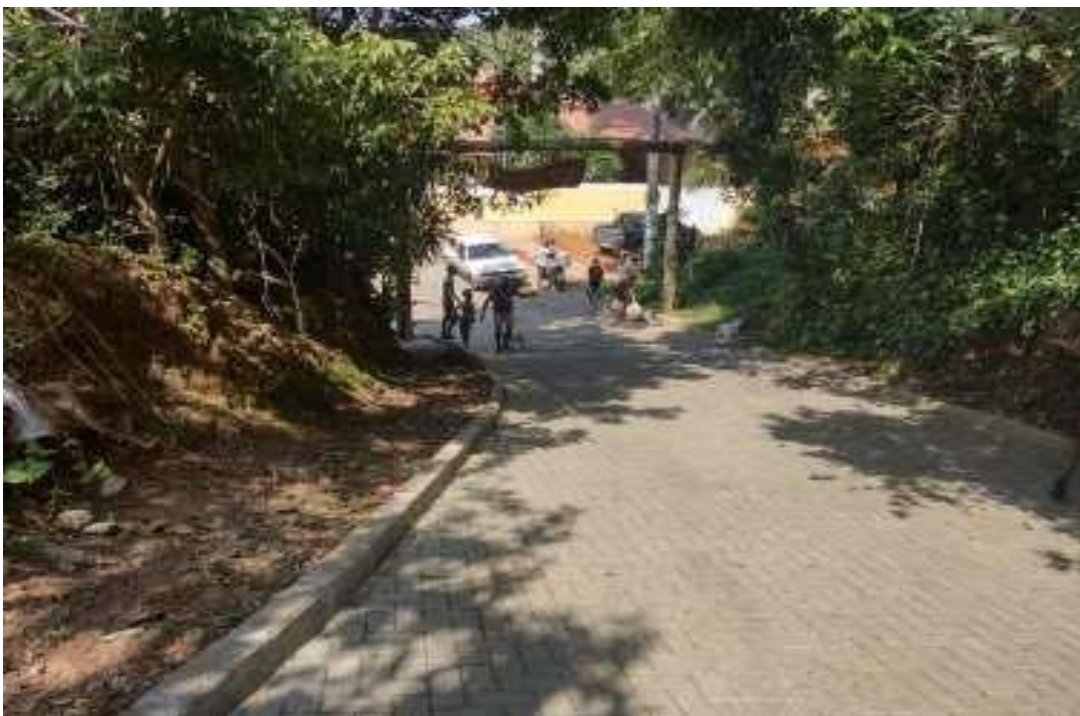
Figura 8: Área com pavimentação com paralelepípedos.
