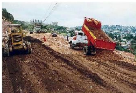
(c) Execução de aterro (PINTO, 1999)
