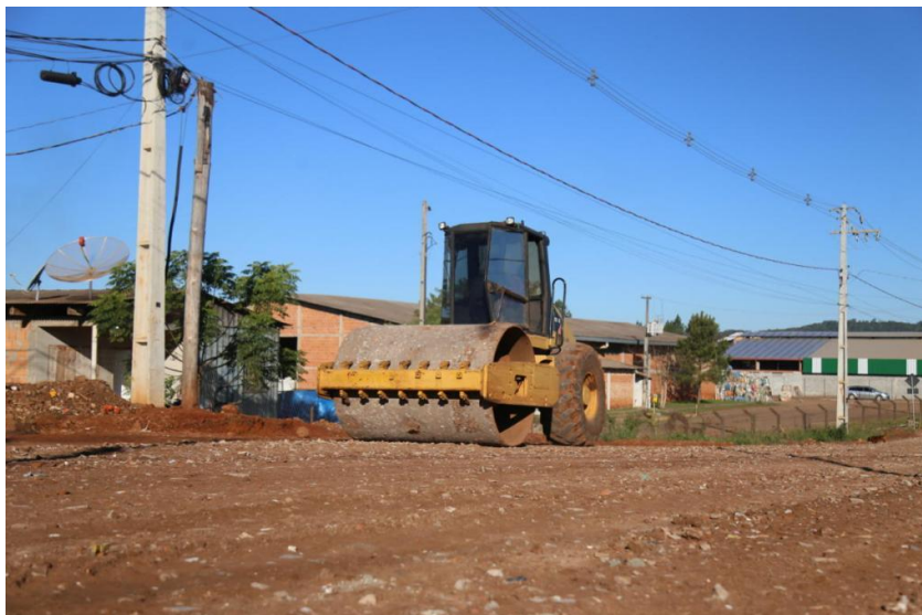
Figura 4 - Pavimentação com RCD
