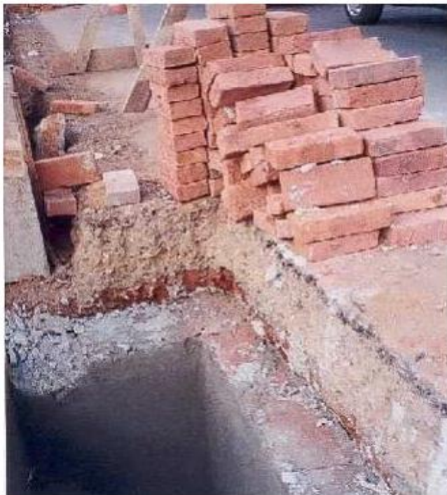
Figura 6 - Corte de um pavimento executado com base de agregados reciclados de RCD em Belo Horizonte.
