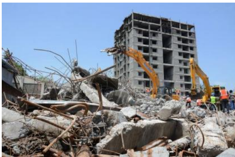
Figura 2 - Resíduos de demolição
