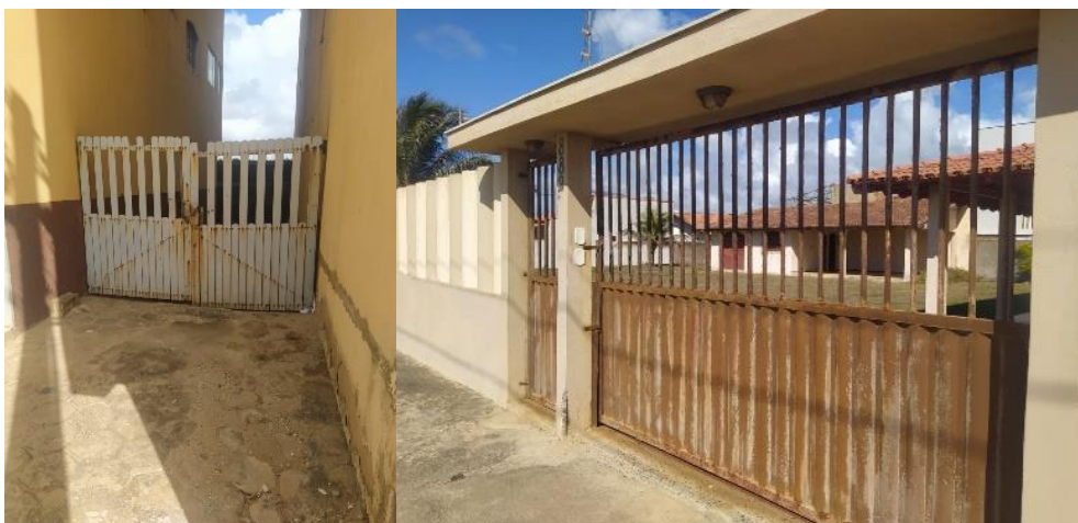
Imagem 6: Portão da fachada em estado de corrosão
