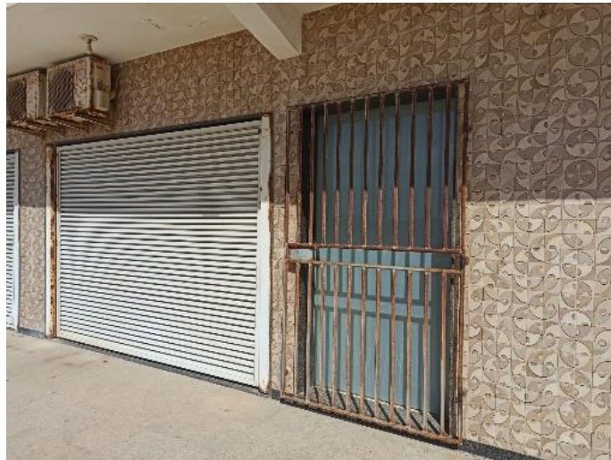
Imagem 6: Portão da fachada em estado de corrosão
