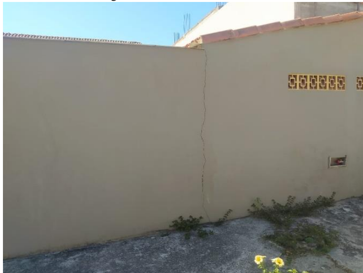
Imagem 2: Fissura em alvenaria de fachada
