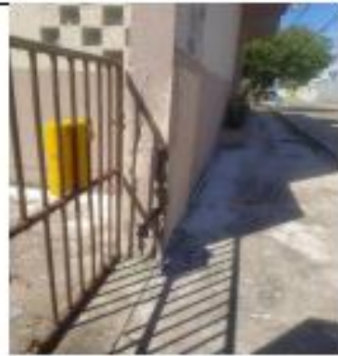
Corrosão de pilar com deslocamento
