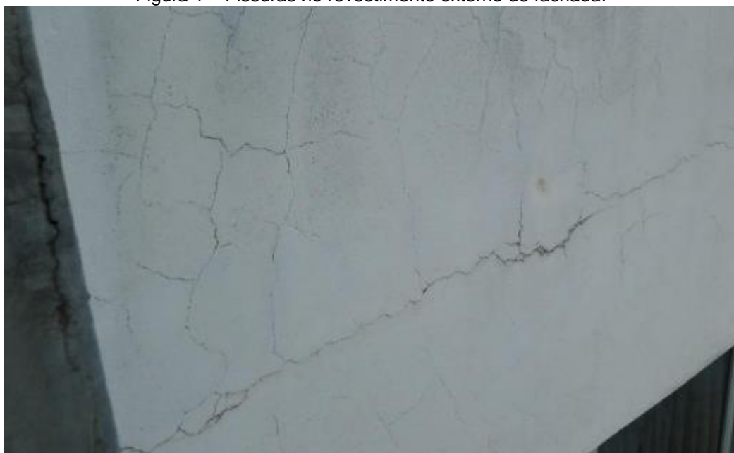
Figura 1 – Fissuras no revestimento externo de fachada.
