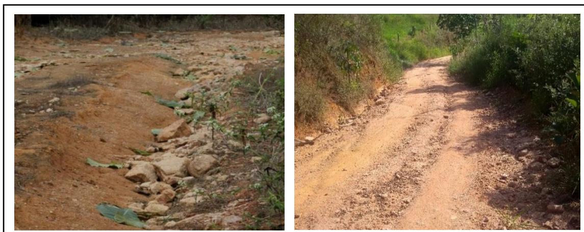
Figura 2 – Trecho da estrada com segregação lateral
