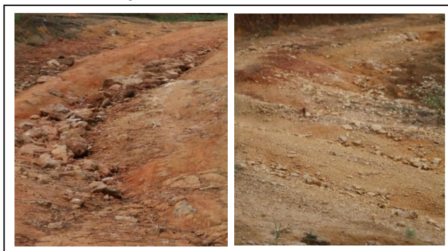
Figura 3 – Trecho com erosão evidenciada
