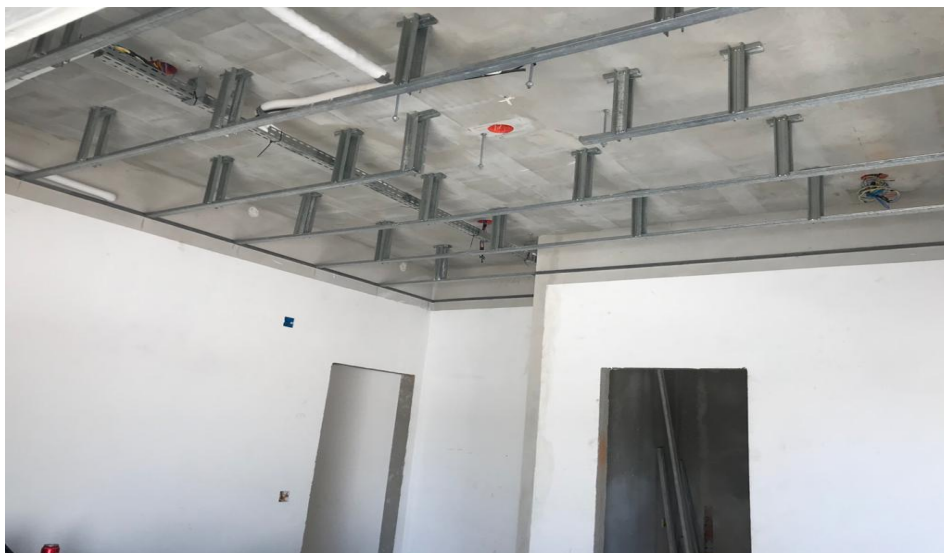
Figura 04 –Armação para colocação de PGA
