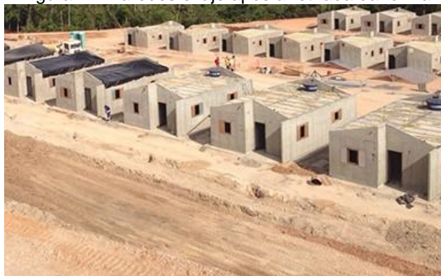
Figura 1 – Paredes e laje após a retirada da forma
