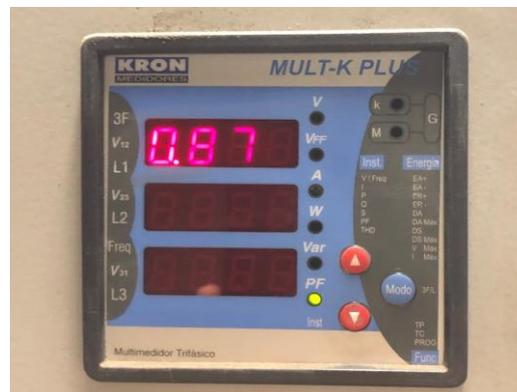
**Figura 05** – Fator de potência após a aplicação do banco de capacitores
