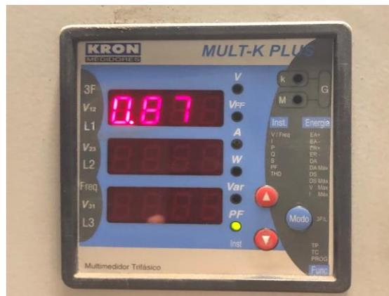
**Figura 05** – Fator de potência após a aplicação do banco de capacitores
