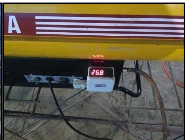
**Figura 10:** Regulador de temperatura do aquecedor. **Fonte:** Arquivo pessoal.
