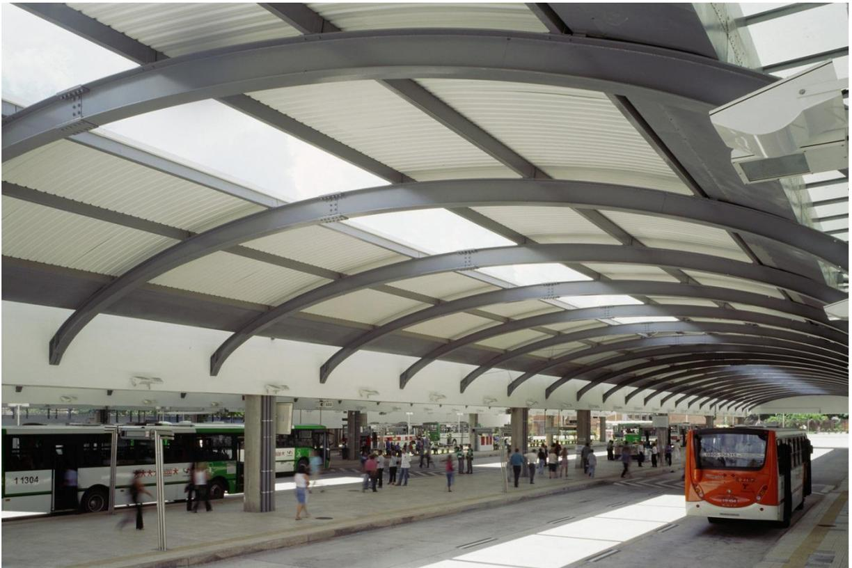
Figura 16: Terminal da Lapa – Estruturas metálicas e vigas longitudinais que permitem a iluminação natural.
