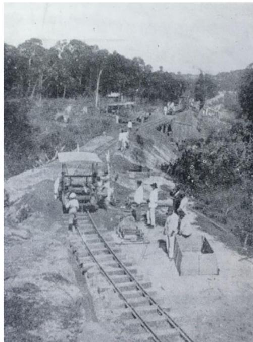
Figura 8: Trilhos sendo assentados no Córrego do Bamburral, KM 4 da ferrovia.
