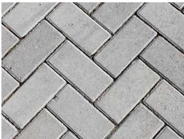
Figura 56– piso de concreto intertravado
