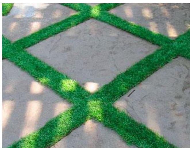
Figura 58– piso de concreto em bloco de 80x80 cm
