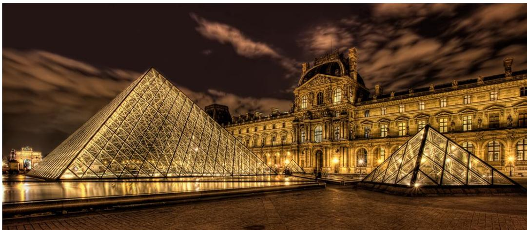
Figura 22: Museu do Louvre. Destaque para a pirâmide estruturada em perfil metálico, e fechamento em vidro.
