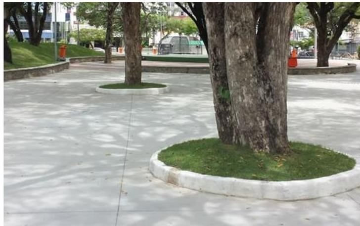
Figura 43 – Exemplo de Piso em concreto polido
