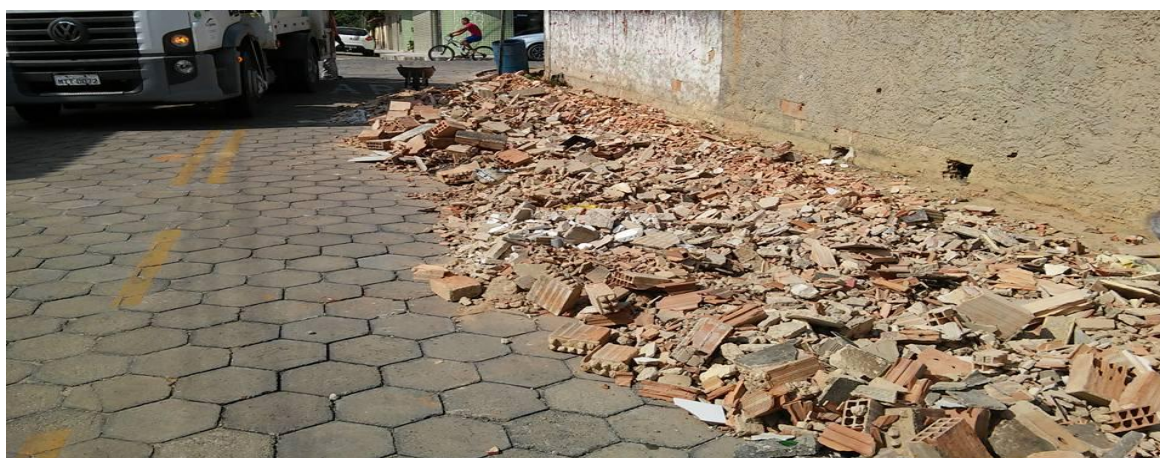
Foto 1: Tijolos e concreto (Classe A) – Rua Cotaxé. Fonte: Foto tirada pelo autor em 23 de Agosto de 2015.
