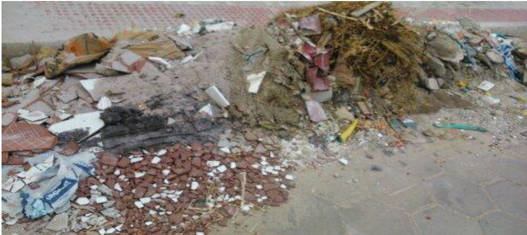
Foto 7 : Cerâmica, areia, plástico de argamassa e cimento – Rua Horizonte. Fonte: Foto tirada pelo autor em 30 de Agosto de 2015.
