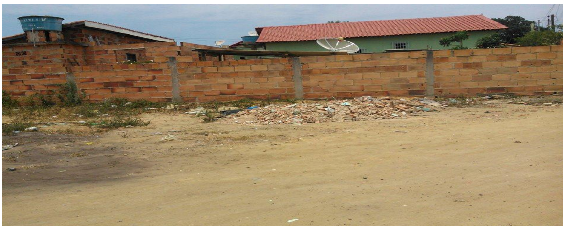
Foto 4: Descarte irregular de resíduos da construção – Lote vago. Fonte: Foto tirada pelo autor em 02 de Setembro de 2015.
