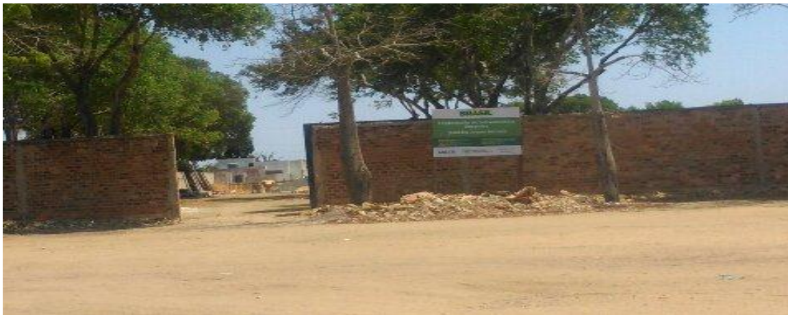
Foto 3: Concreto oriundo da obra do Estádio Municipal. Fonte: Foto tirada pelo autor em 25 de Agosto de 2015.
