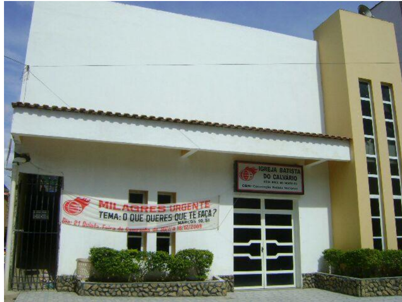
Figura 04: Fachada Igreja Batista do Calvário antes da reforma. Fonte: Pr. Charles Rodrigues, 2009.
