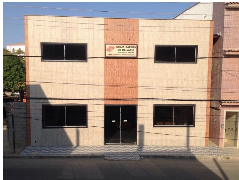
Figura 05: Atual fachada da Igreja Batista do Calvário. Fonte: Autores, 2016.
