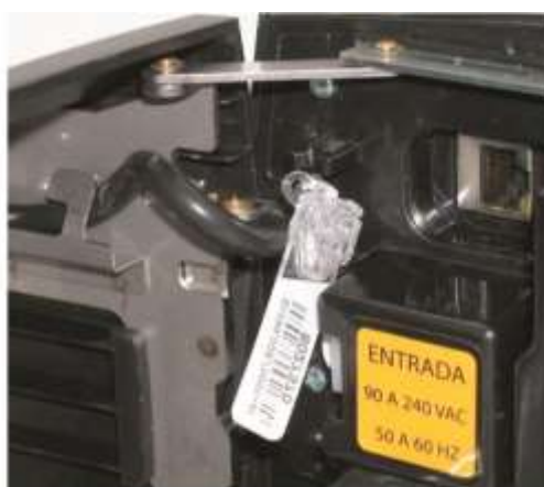
Figura 7 – Instalação e ligações do relógio
