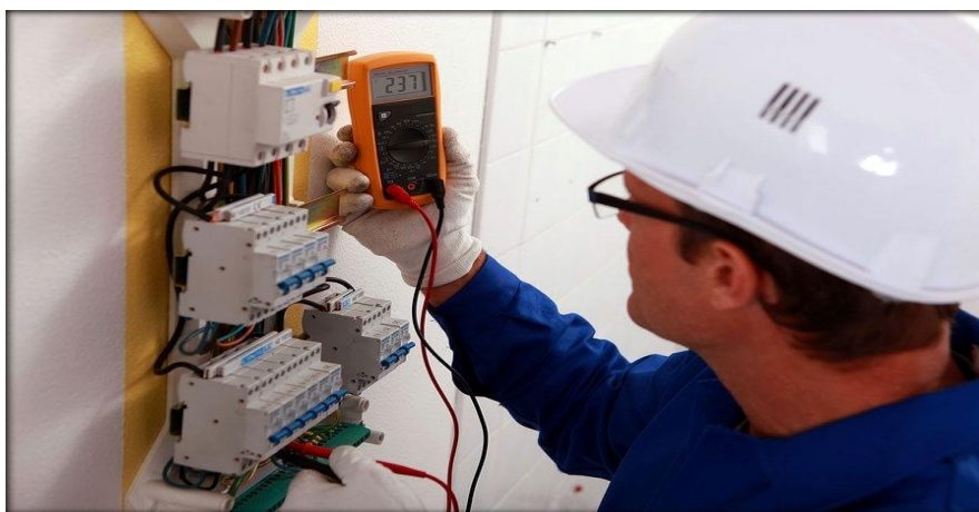
Figura 4: Técnico executando manutenção elétrica preventiva
