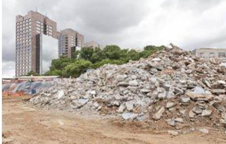
Figura 2.8 – Destinação inadequada de RCD's em local urbano
