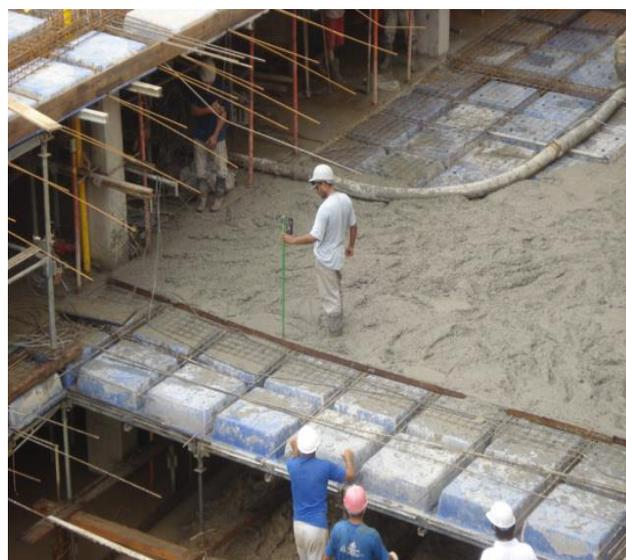
Figura 2.15 – Execução da laje nervurada
