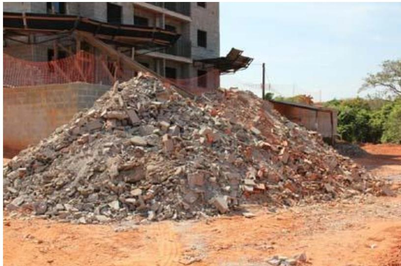
Figura 2.1- Parte de entulho gerado em uma obra
