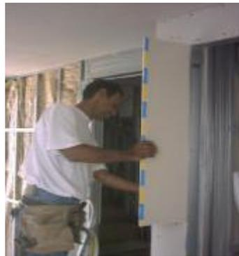
Figura 11 - Instalação do fechamento interno utilizando o gesso acartonado
