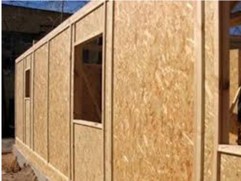
Figura 4 - Montagem placas OSB
