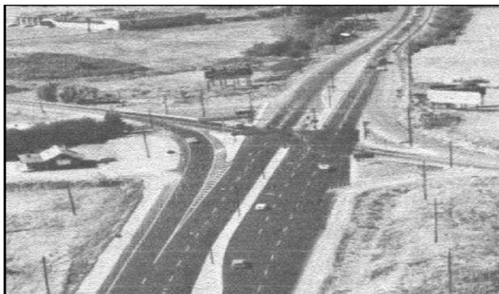
FIGURA 4 - INTERSEÇÃO CANALIZADA Fonte: Manual de projeto de interseções-DNIT, 2005.
