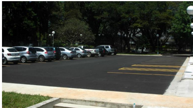
Figura 9 – Obra concluída do estacionamento do Centro Tecnológico de Hidráulica da Universidade de São Paulo – USP. Fonte: Centro Tecnológico de Hidráulica da USP, 2009.
