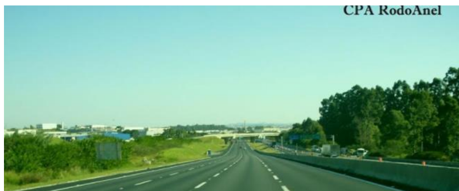
Figura 11 – Obra Concluída na Rodovia Rodoanel em São Paulo. Fonte: Empresa City (2017).
