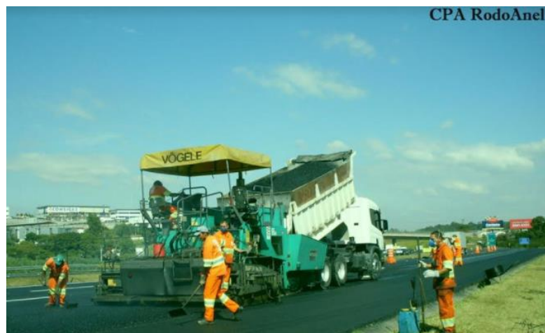
Figura 10 – Execução da implantação do CPA na Rodovia Rodoanel em São Paulo. Fonte: Empresa City (2017).
