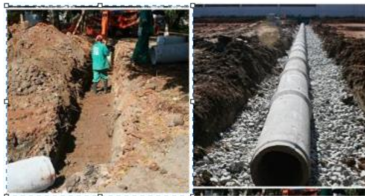
Figura 5 – Execução da obra de drenagem no estacionamento do Centro Tecnológico de Hidráulica da Universidade de São Paulo – USP.
