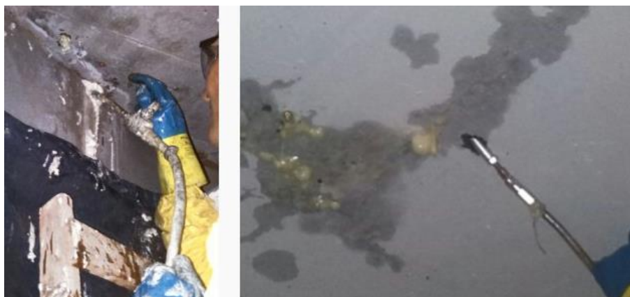
Figura 12: Injeção de epóxis. Fonte: Metta Construções (2016)
