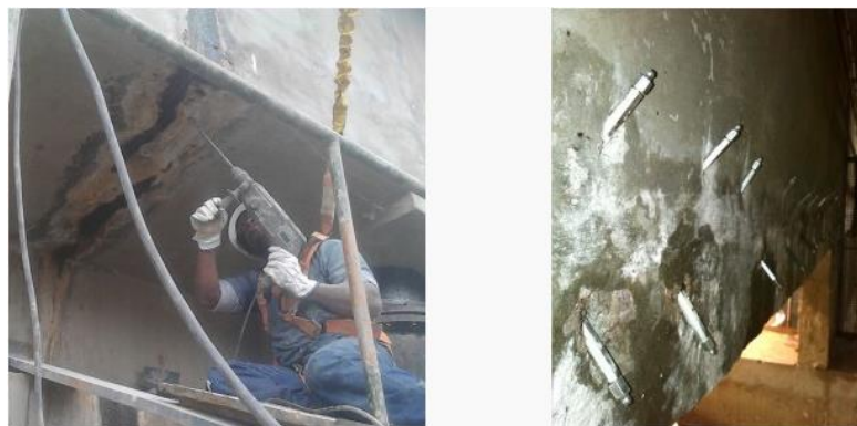
Figura 11: Furo e introdução dos tubos. Fonte: Metta Construções (2016)
