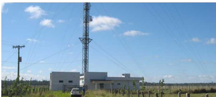
Figura 2 – Torre metálica treliçada e estaiada Fonte – Levantamento técnico, município de Sooretama/ES.
