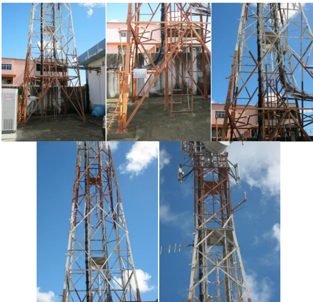
Vista das peças da torre de h=30m.
