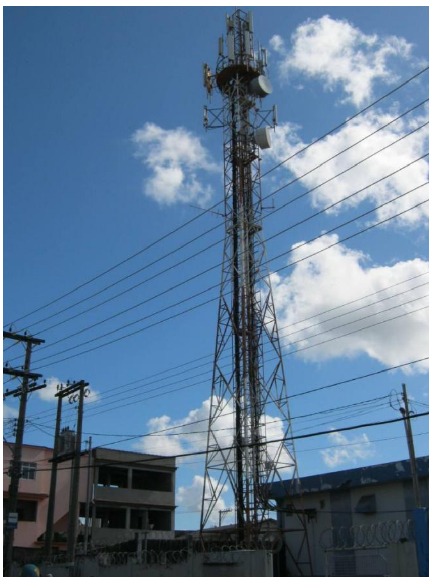
Vista da geometria da torre de h=30\text{m} .
