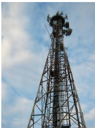
Figura 3 – Torre metálica treliçada autoportante Fonte – Levantamento técnico, município de Cariacica/ES
