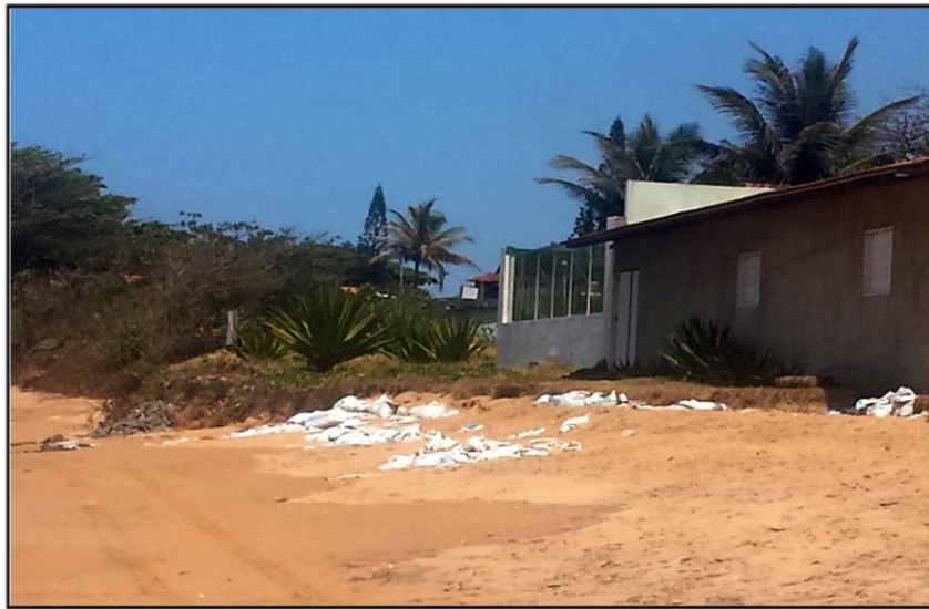
Figura 8 – Sacos de areia para contenção Fonte: Propria
