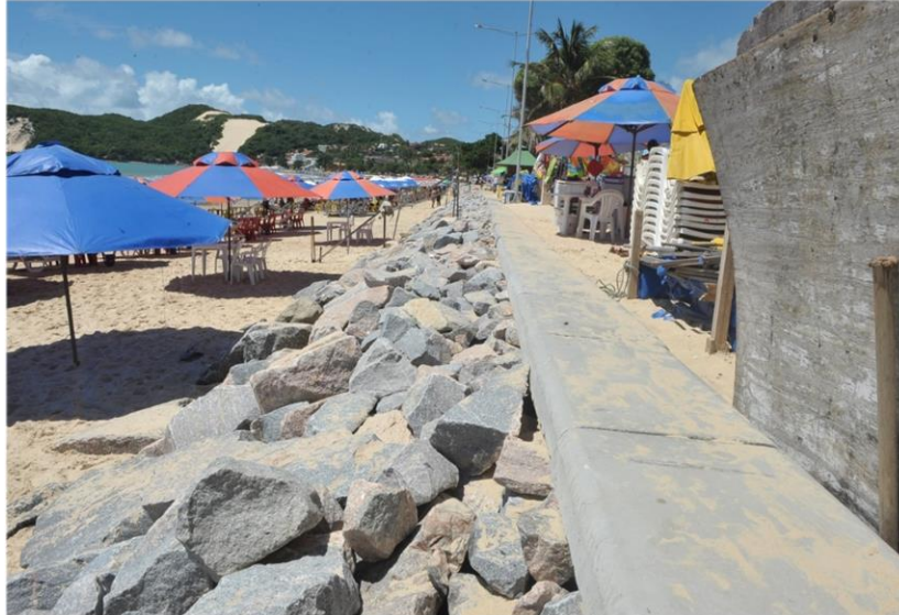
Figura 3 – Exemplo de contenção rochosa Fonte: Google Earth
