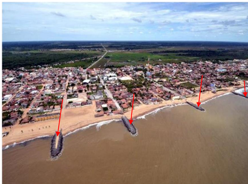
Figura 4 – Exemplo contenção com uso de Espigões, demarcado com setas vermelhas Fonte: Google Earth
