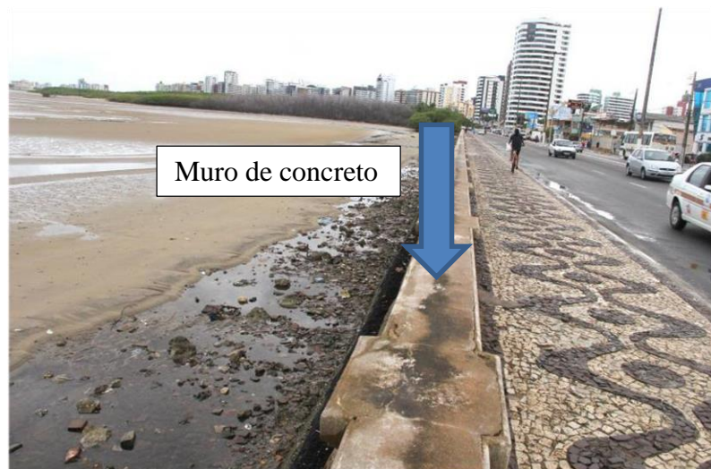
Figura 1 – Exemplo muro de contenção de concreto Fonte: Google Earth
