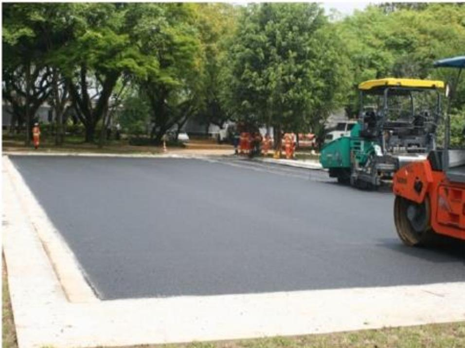
Figura 4: Implantação do concreto poroso asfáltico.
